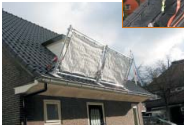
het ArboDak- vangnet. Een collectieve beveiliging die zowel onder aan het dak als halverwege het dak kan worden geplaatst. Daarmee is het de eerste beveiliging die voldoet aan de nieuwe Europese norm EN 13374 in de zin van een voorziening op ieder 5 meter daklengte.
