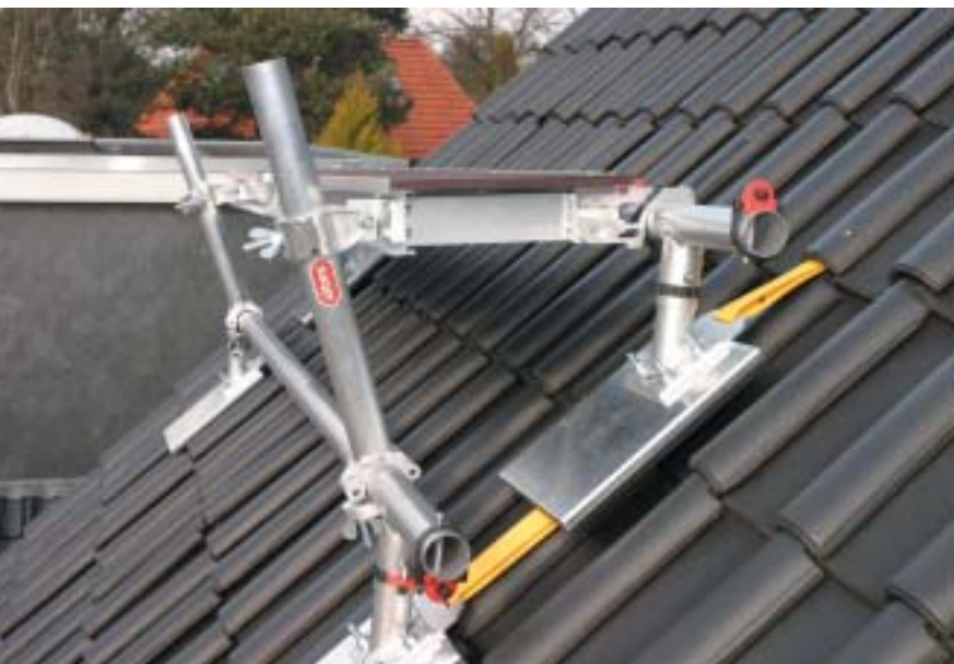
Het ArboDak-bordes. Een werkhulp voor de dakdekker en ook deze is daar op het dak te klikken waar deze nodig is. Het dakbordes mag uiteraard alleen gebruikt worden in combinatie met het vangnet.
