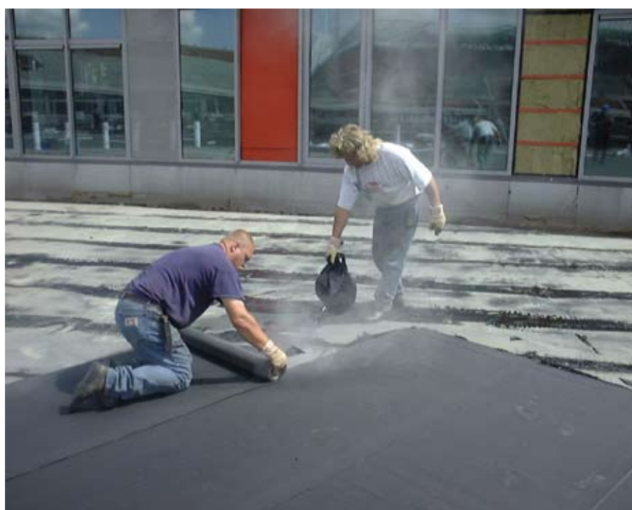
Twee lagen volledig gekleefde dakbedekking
