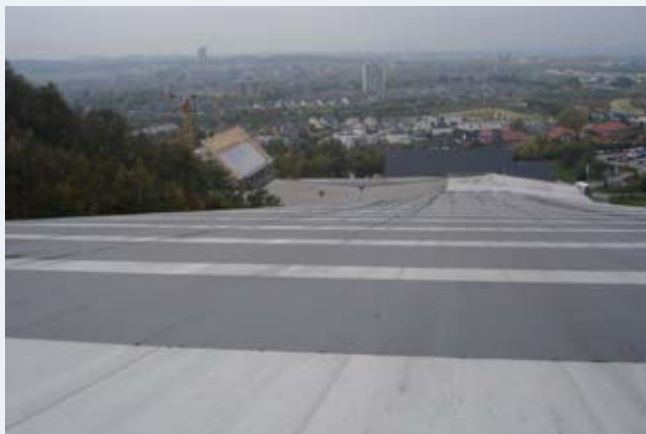
Bovenaanzicht van het dak van de skibaan. Links op de foto het in aanbouw zijnde hotel.
