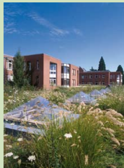
Omgekeerd dak met gecombineerde dakbegroeiing
