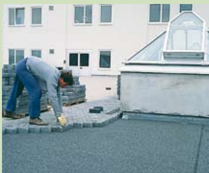
Omgekeerd dak: uitvoering met bestrating
