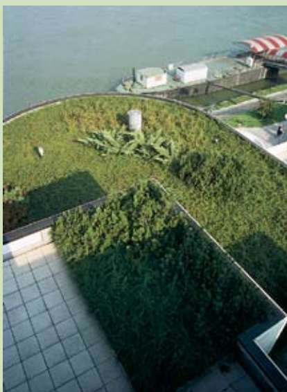
Omgekeerd dak, uitvoering terrasdak en begroeid dak
