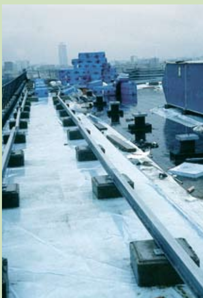
Bescherming van dakbedekking door installatie op de isolatie
