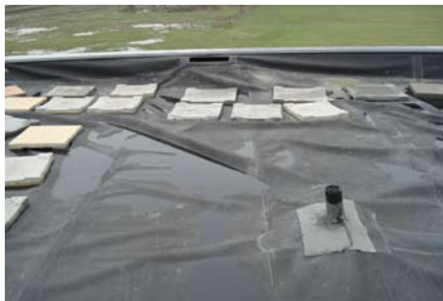
Schade mechanisch bevestigde EPDM
