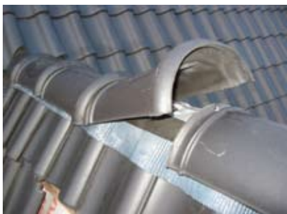
Opgewaaiide nokvorsten als gevolg van gebrekkige bevestiging
