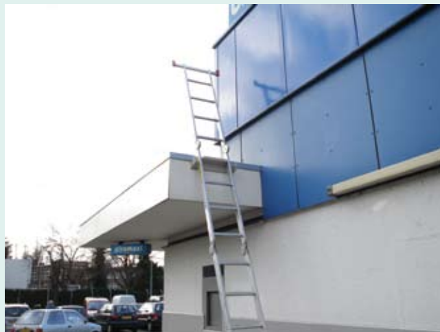
Het ladderborgingspunt is netjes om de hoek van de voorgevel weggevoerd. Samen met het bord "Ladderborgingspunt" kan dit op in het oog springende locaties ontsierend werken. Alleen, probeer maar eens vanaf de ladder het dak op te stappen.
