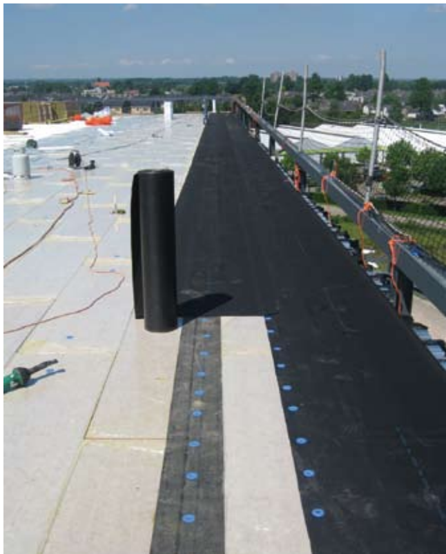
Dakvlak met tussenliggende bitumineuze stormbaan
