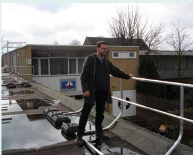
Directeur Laurens Smets op het demonstratiedak van Gevaco, waar verschillende valbeveiligingssystemen staan opgesteld
