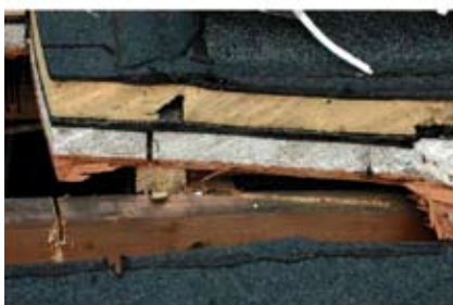
Foto 2 Zichtlijjk is de meeste steekbewerking van de draagende balklaag en het rookglas dakbedekking
