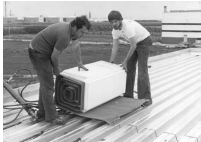
Chris Appels (rechts op de foto) helpt, eind jaren '70, op een dak van Spuitco met het leggen van een Unidek Kantelrol, de voorloper van de klapbaan
