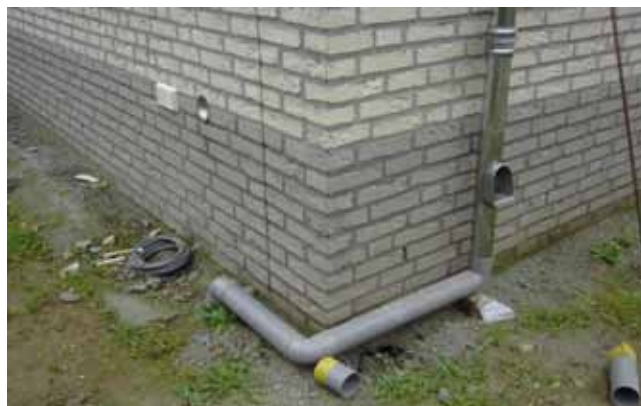
gescheiden hemelwaterafvoer met bladrooster
