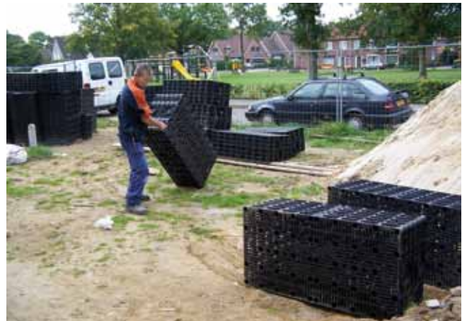
aanbrengen elementen bodeminfiltratie hemelwater
