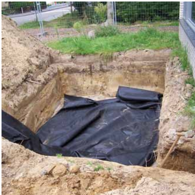
gat bodeminfiltratie hemelwater met filterdoek
