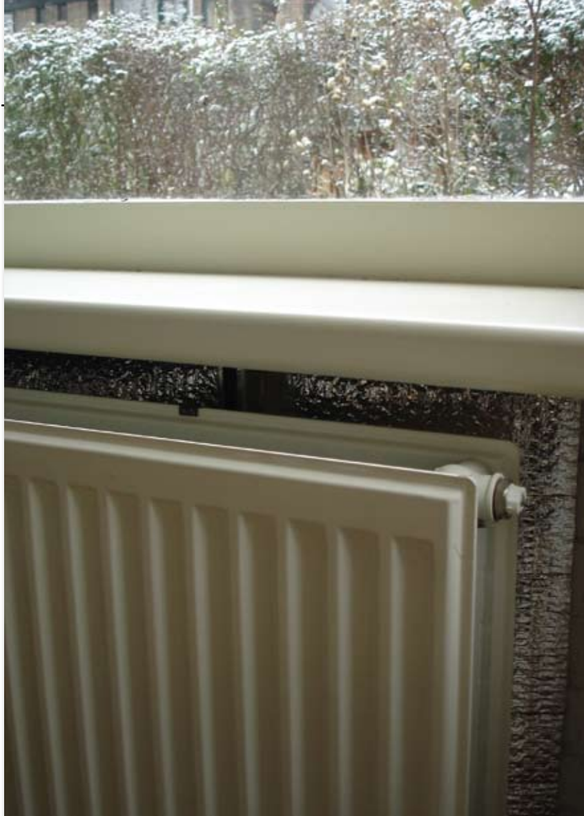
Met een reflectiefolie achter de verwarming kan een aanzienlijke besparing worden bereikt.
