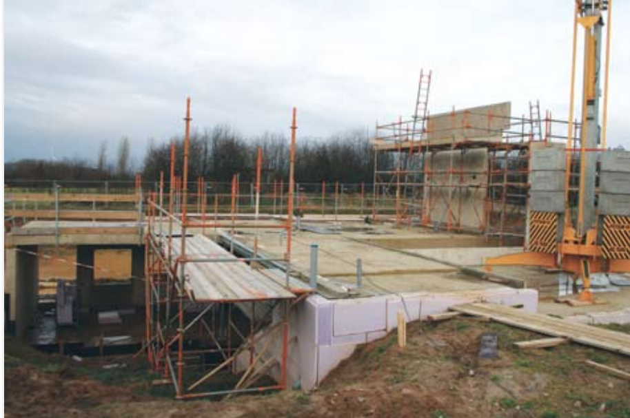
Inmiddels is begonnen met de bouw van het eerste pand, 'Knik naar de zon'.
