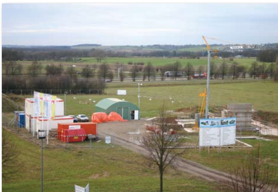
Het terrein van Avantis, waar De Wijk van Morgen op zal worden gebouwd.
