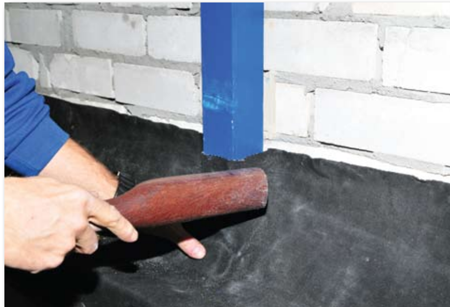
Een toepassing van de loodvervanger Ecoflex.
