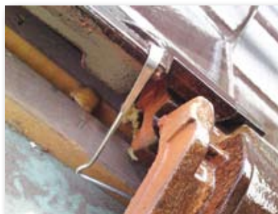
Panhaak met te lange inslagpen met geringere rekenwaarde.
