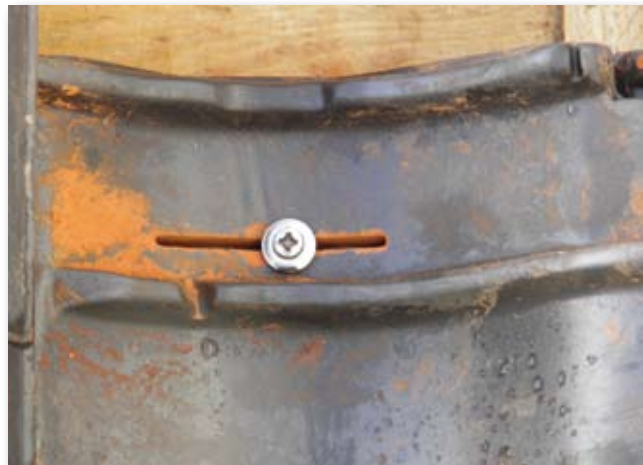
"Gat" voor schroef geboord met slijptol: echter met lekkage.
