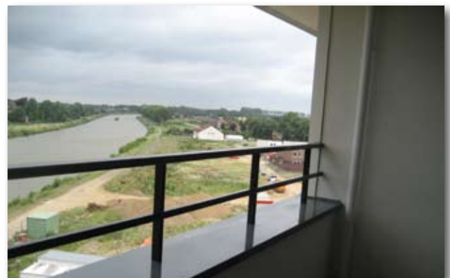
Baluster met dubbele railing.
