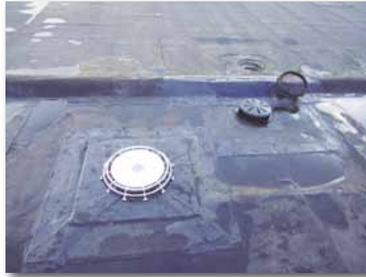
◀ Noodoverloop in het dakvlak.
