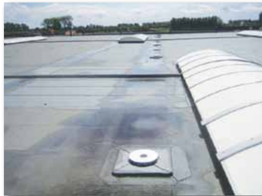
◀ Bijplaatsen noodoverloopen in de gootlijn
