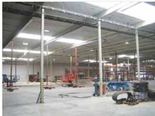
◀ Constructief versterken van de dakliggers.
