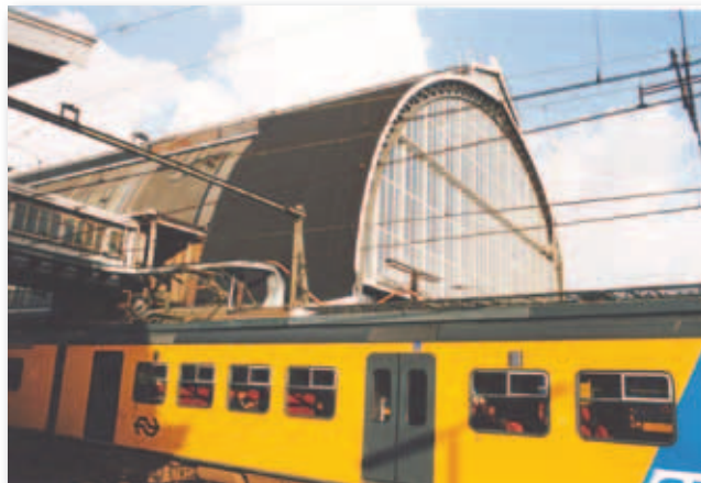
Het dak van het Centraal Station van Amsterdam is in 1994 bedekt met EPDM.
