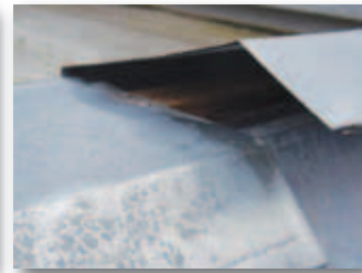
Overlap 10 mm en geen afdichting
