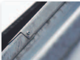
Afdekkers aan elkaar geschroefd met geringe overlapping
