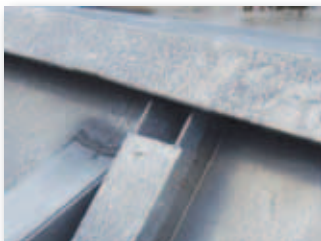
Aan de nok ontstaat ruimte als de afdekker afzakt
