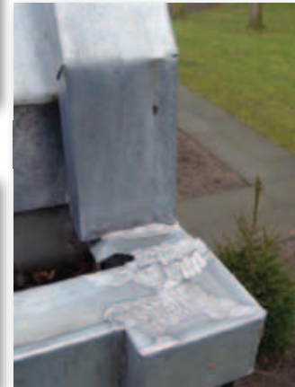
Knip, zet en soleerwerk
