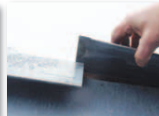
Soldeerverbinding ontbreekt
