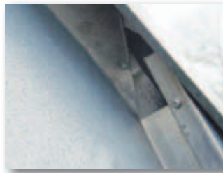
Hoekkeper aansluiting met gaten
