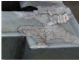
Uitgevoerd soldeerwerk
