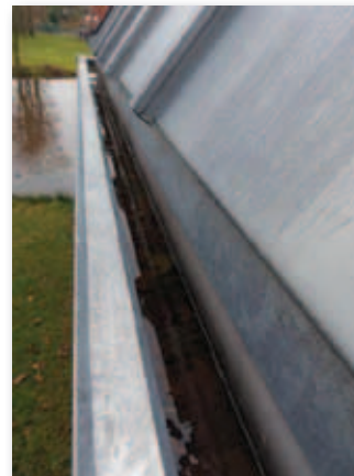
Epdm-goot met zinken afdekking
