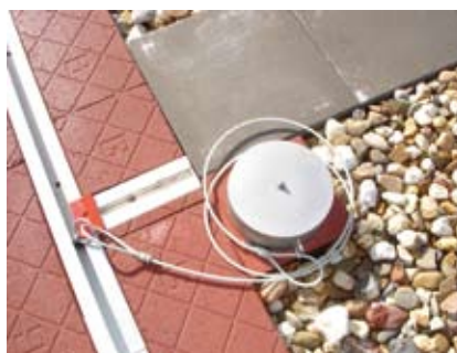
Aankoppelstation vaste veiligheidslijn in systeem
