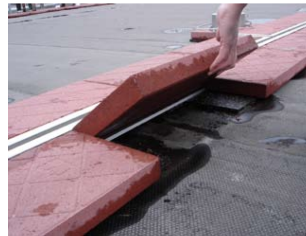
Aankoppelstation vaste veiligheidslijn in systeem
