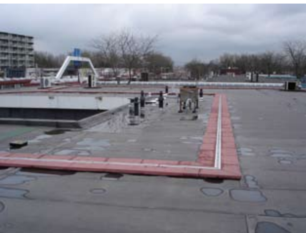
Winkelcentrum Hesseplaats in Rotterdam
