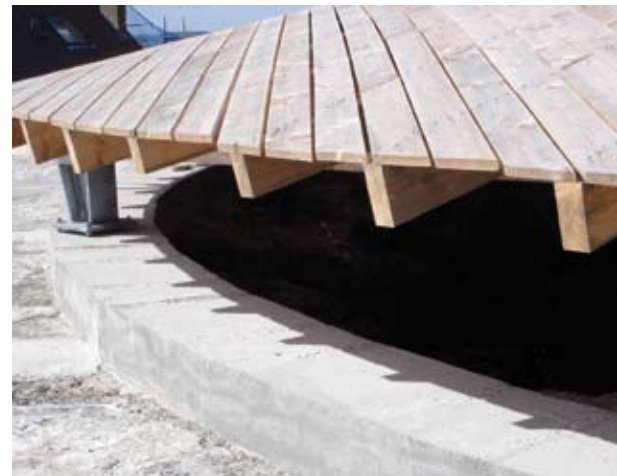
De houten koepels staan op stalen voeten
