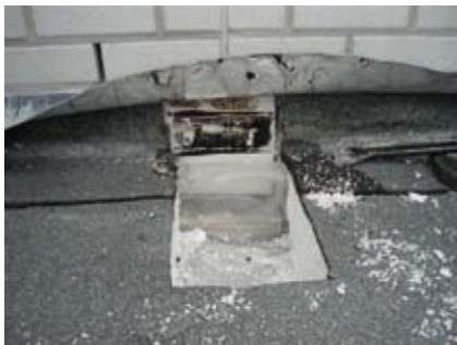
Insnijding in de dakbedekkingsconstructie
