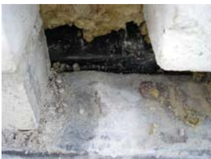
Metselwerk openhakken, controle functioneren voetlood
