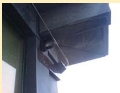
Speciale bevestiging voor de hoekbocht
