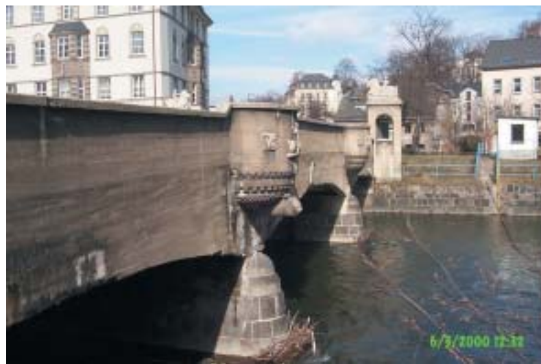
De brug in originele staat
