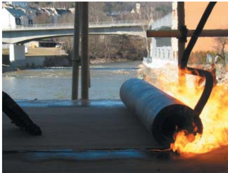
Aanbrengen Eshagum IM-Combi 1
