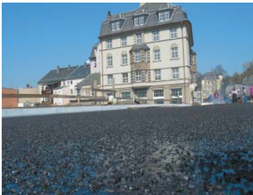
Aangebrachte eerste laag gietasfalt
