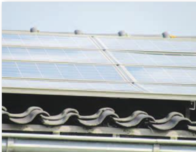
Systeem golft over het dak.
