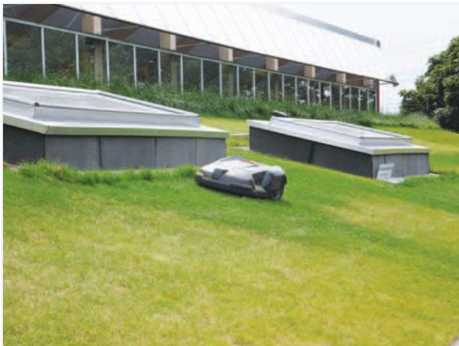
Dak van het gebouw van Groen filter dak van Helvoirt in Berkel Eschot. Dit speciale dak ontving een eervolle vermelding Green Building Award vanwege de hoge score voor innovatie, het watersysteem op het dak. Het innovatieve filterdak is tot stand gekomen door samenwerking in het bouwteam plus. Daarbij werkten Van Helvoirt Groenprojecten, SHFT, Ecofyt en Équipe voor architectuur en urbanisme samen met bouwende partijen.
