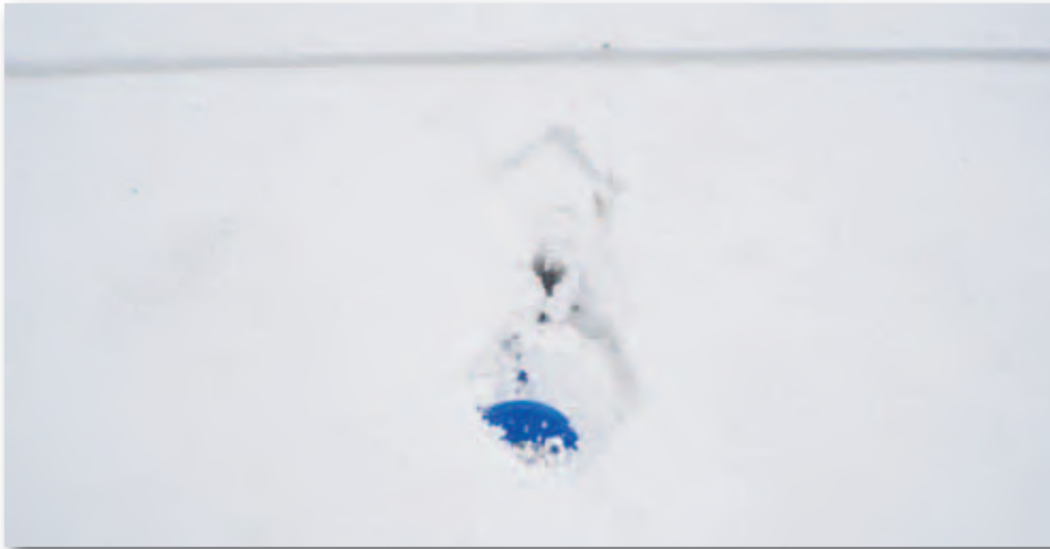
Bevestiging voldoet niet.
