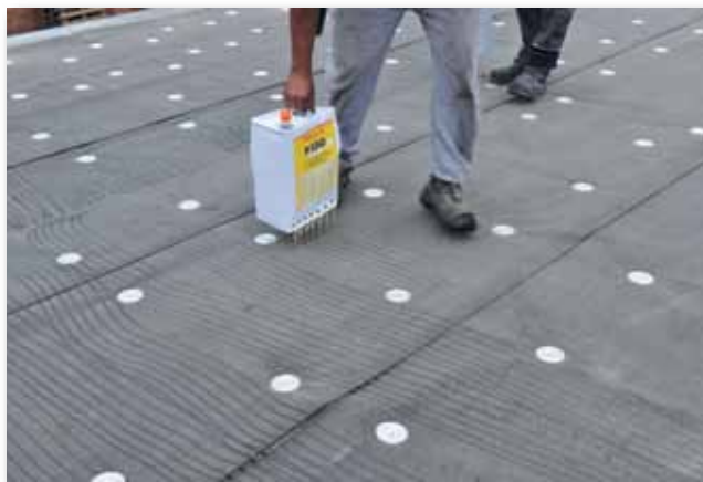
Op de ondergrond wordt nieuwe P150 bodemlijm particeel aangebracht.
