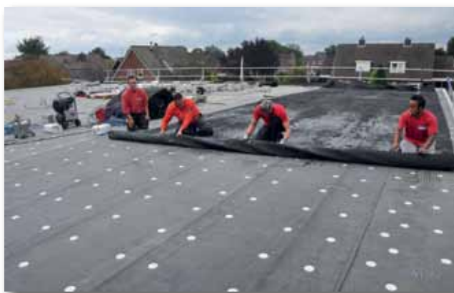
De EPDM membranen worden in de P150 bodemlijm gerold.
