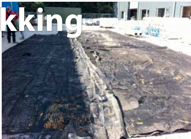
De gedemonteerde membranen bij EPDM Systems controleren en opnieuw opvouwen.
