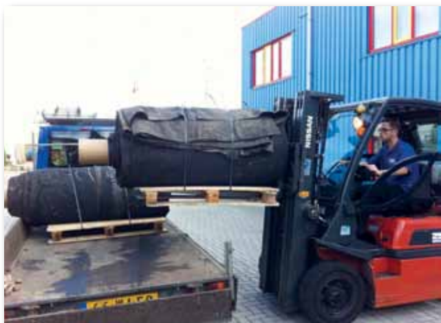
De opgerolde membranen worden geladen voor transport naar het dak.
