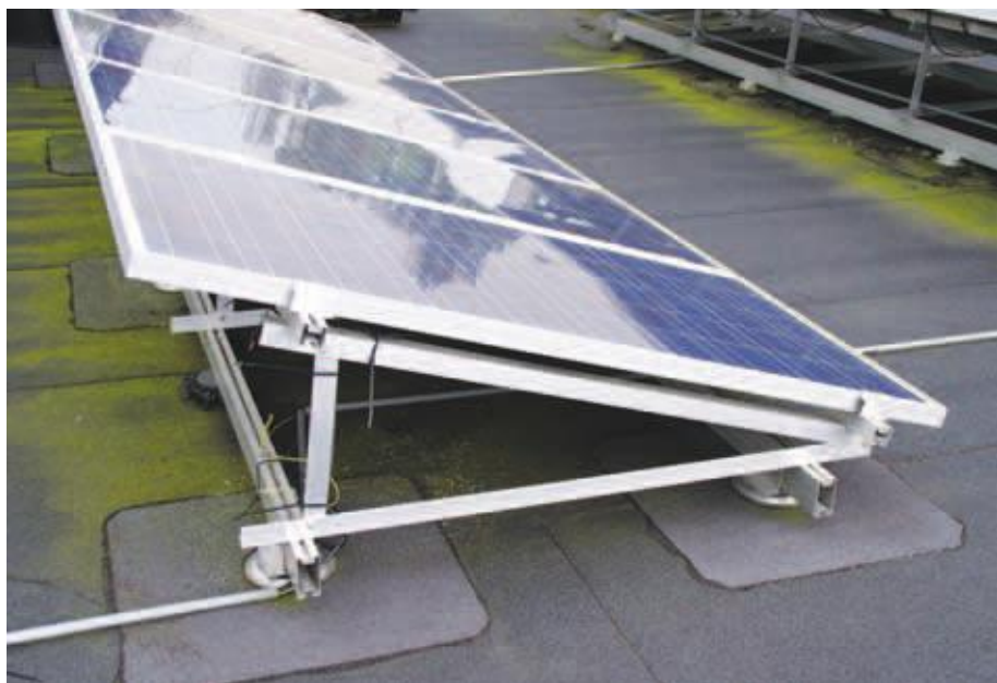
Figuur 9, Zonne-element onder een hoek gepositioneerd en mechanisch bevestigd
