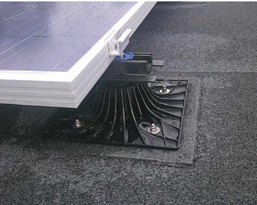
Figuur 8, Voorbeeld gekleefde bevestigingspunten aan dakbedekking
