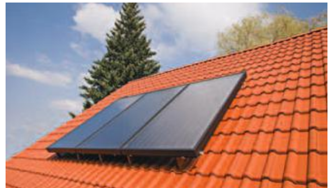
Figuur 2: Illustratie van Montagewijze 2 (op hellend dak)
