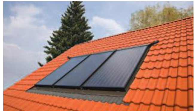
Figuur 1: Illustratie van Montagewijze 1 (op hellend dak)
