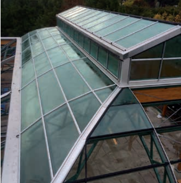
Detailopname van de aansluiting van het bovenste dakvlak op de nokopbouw. In de langszijde van de nokopbouw zijn (2x) 10 te openen ramen opgenomen.
