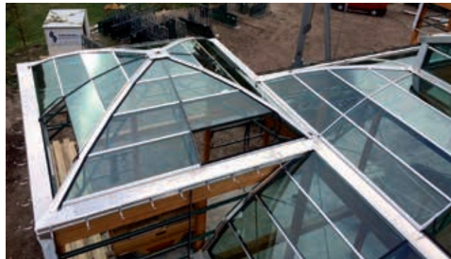
Detailopname van één van de torentjes in de voorgevel. De beugels voor de mastgoot zijn al aangebracht. De platte delen tussen goot en glas (en tussen het bovenste en onderste gebogen dakvlak) zijn de aluminium gootplanken.
