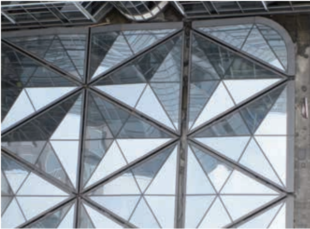
Hier is het breedteverschil van één van de rechtdoorlopende goten te zien. Het dak heeft een ronde rand wat bij de maatvoering van de beglazing van de piramides om nauwkeurigheid vroeg.
