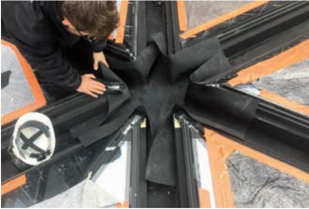
Voor de dakbedekking van de zessprong en andere hoekaansluitingen zijn broekstukken geprefabriceerd, waarvan de maatvoering van tekening is gehaald.
