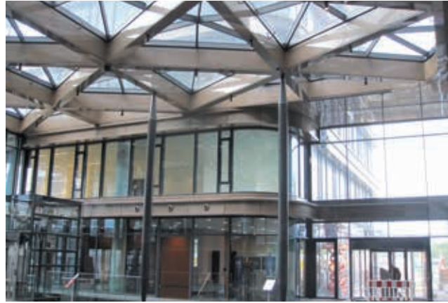
De overkapping van de entree ruimte ligt op het niveau van de tweede verdiepingvloer. De constructie wordt gedragen door slanke kolommen.
