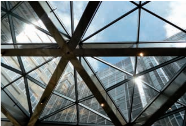
Beeld vanuit de entree ruimte. De stalen balken met daarboven ruimte voor allerlei voorzieningen alsmede de draagpootjes van de piramides zijn afgewerkt met aluminium plaatwerk.
