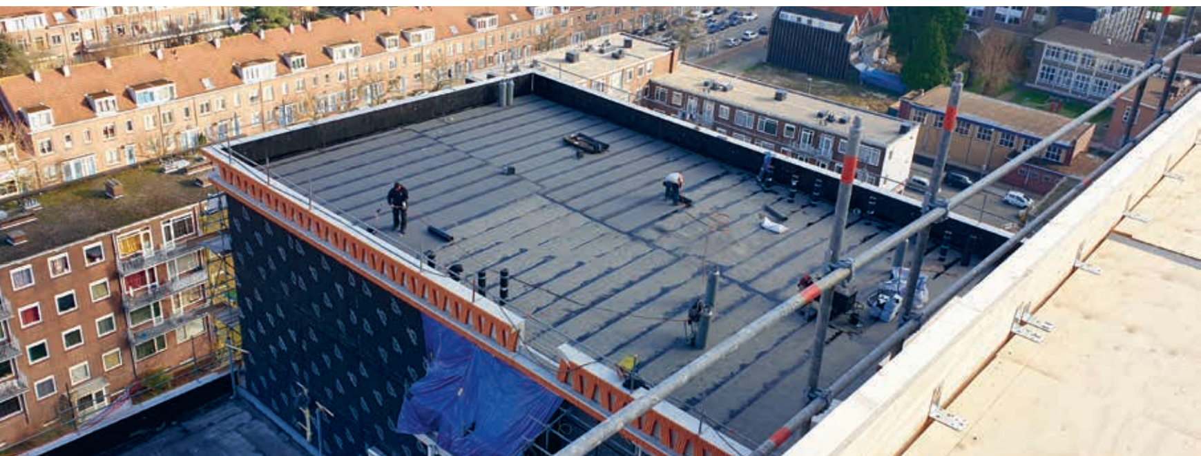
Het dak van de sportkooi met omloop wordt afgewerkt met bitumen. (Foto: De Bruijn Dakbedekkingen)
