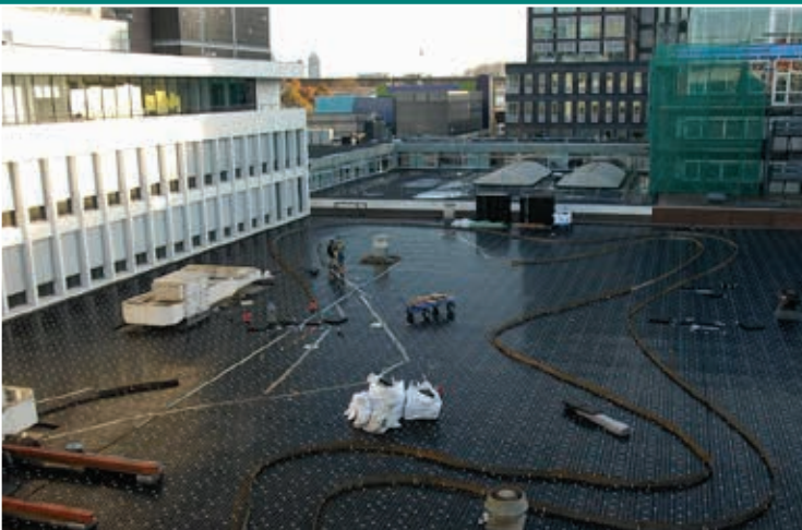
Kantoorgebouw Vivaldi na en tijdens de aanleg van een polderdak.
