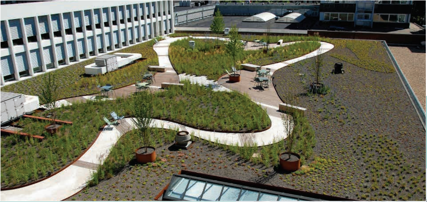
Kantoorgebouw Vivaldi na en tijdens de aanleg van een polderdak.
