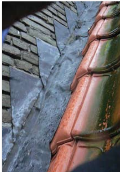
Profilering en verwerking van lood rondom een schoorsteen. Zowel het profileren als de voetlood verwerking geeft problemen.
