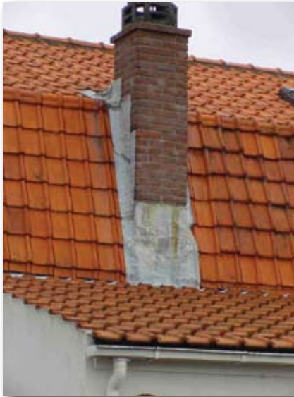
Erg lang voetlood en zeer hoge loketten; niet mooi en loketten (tenminste 10 lagen hoog) erg gevoelig voor opwaaien.
