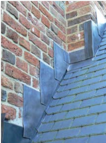
Loketten aan afhangende lange zijde dubbel gezet, verankering (kort boven onderliggende loket) kan achter de dubbele zetting weggewerkt worden..
