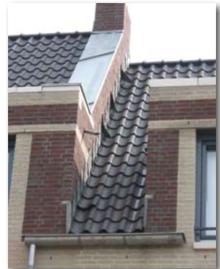
Loketten waaien op onder invloed van wind.
