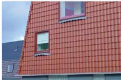
Vooraf afhankelijk lood vereist bevestiging middels b.v. klagen. Geplisseerd lood onder dakvensters is vaak van zeer lichte kwaliteit (soms lichter dan code 10). Maatregelen tegen opwaaien zijn noodzaak.
