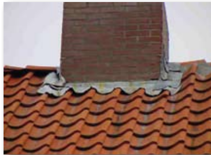
Profilering en verwerking van lood rondom een schoorsteen. Zowel het profileren als de voetlood verwerking geeft problemen.
