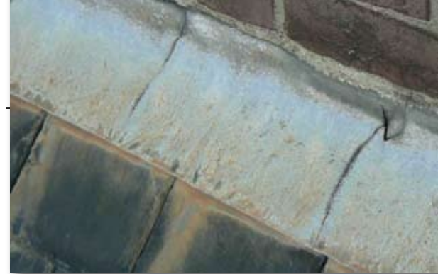
Scheuren door plooi vorming.
