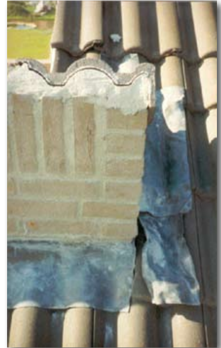
Voetlood tot einde metselwerk, en geen centimeter meer!
