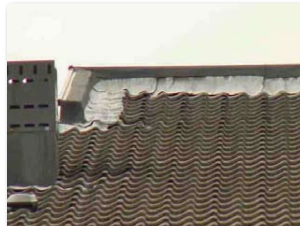
Vooraf afhankelijk lood vereist bevestiging middels b.v. klagen. Geplisseerd lood onder dakvensters is vaak van zeer lichte kwaliteit (soms lichter dan code 10). Maatregelen tegen opwaaien zijn noodzaak.
