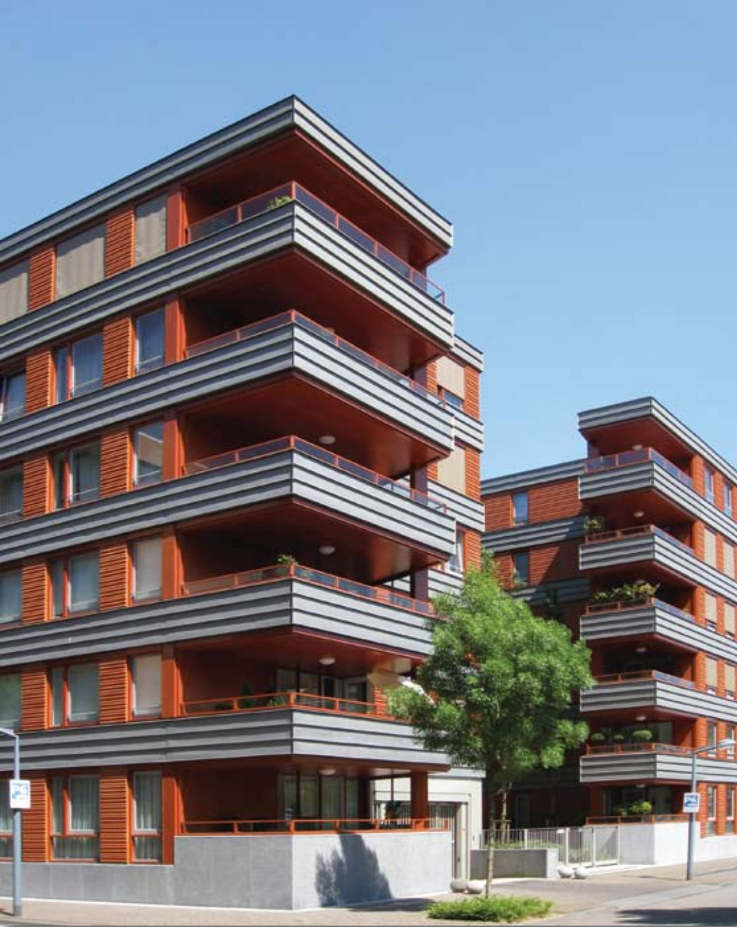
Foto uit Leren van instortingen . (Woongebouw patio Sevilla in Maastricht).
