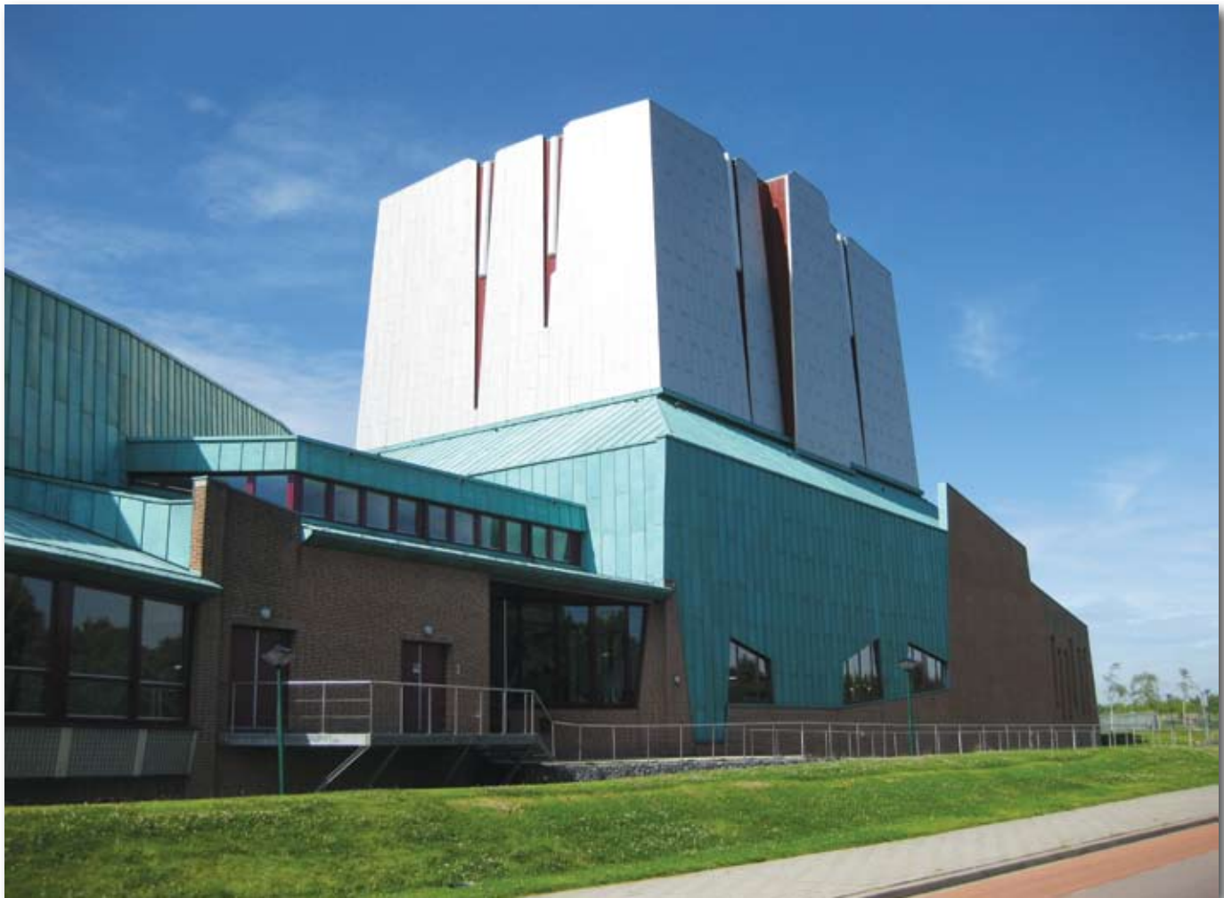
Foto uit Leren van instortingen . (Theater Schouwburg Het Park in Hoorn met de 27 m hoge toneeltoren. Tijdens de aanbouw stortte deze toren in, op 10 april 2001).
