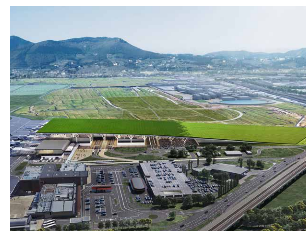
^ Op het dak komen vruchteloze wijnstruiken, druiven worden straks geplukt op het grondlichaam (rechts).
