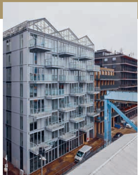
Een licht getint gebouw met verspringende balkons en als blikvanger de kassen op het dak.
