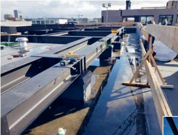
Aanleg van de staalconstructie voor de sportkooi. (Foto: Pleijsier Bouw)
