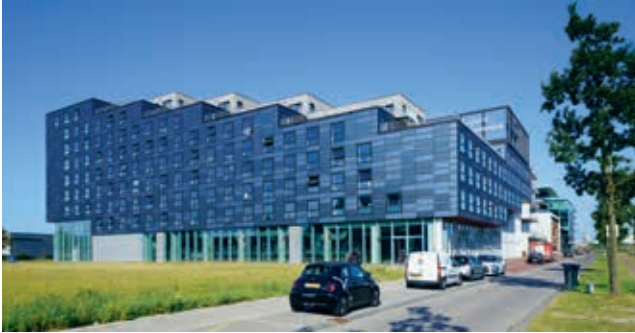
Een fors gebouw met de PV-panelen verwerkt in de gevels.
