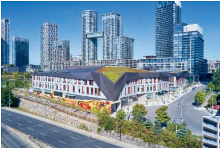
Aluminium gevelsystemen vormen de omkadering van de vele daken.
