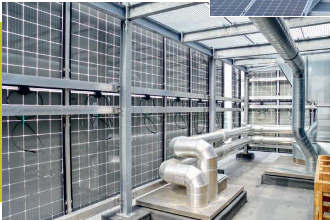
Een verankerde staalconstructie en een montagesysteem waar alle onderdelen op elkaar zijn afgestemd en berekend.
