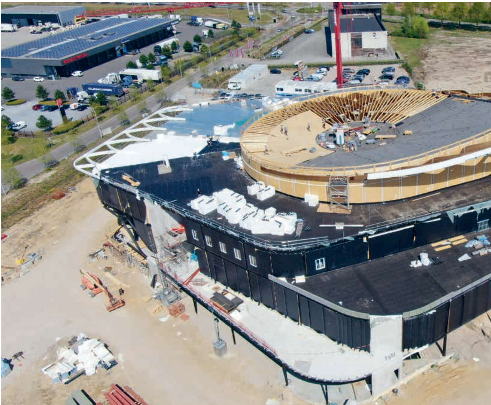
Op deze foto wordt het tweede staaldak voorzien van isolatie en bitumen en is Klander net begonnen aan het bovenste, houten dak. (Foto: Dakned)
