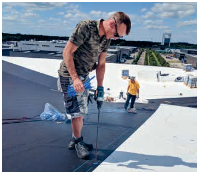
Werken op een hellend vlak: montage van het dakpakket met tules en schroeven. (Foto: Dakned)
