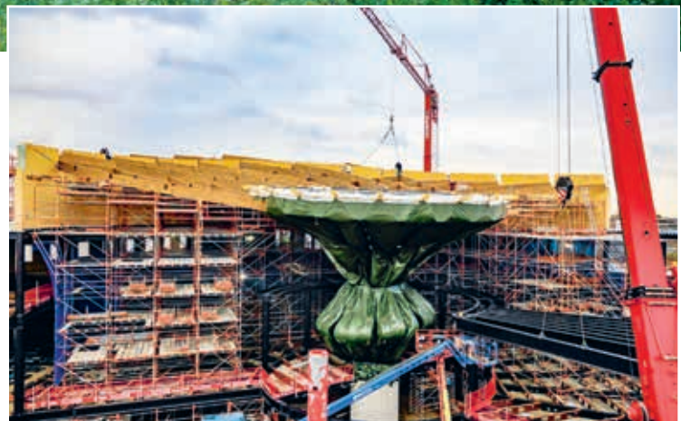
Constructie van het houten dak met centraal de (ingepakte) houten bloemsteel. (Foto: Jos Göritzer)
