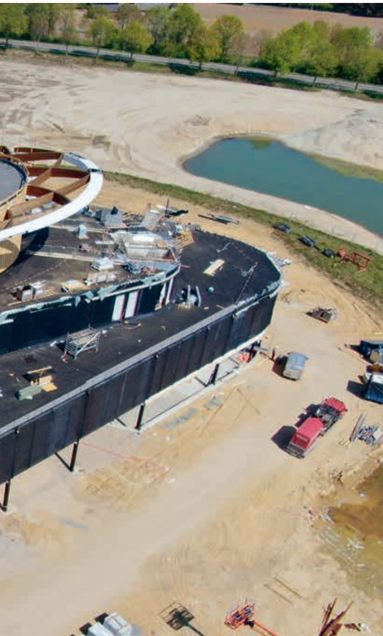
Werken op een hellend vlak: montage van het dakpakket met tules en schroeven. (Foto: Dakned)
