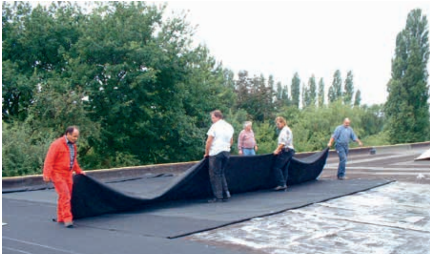
Najib (links): "EPDM is een dakbedekking waarbij wij vooral in de beginjaren zeer veel begeleiding gaven aan dakdekkers op de projecten."
