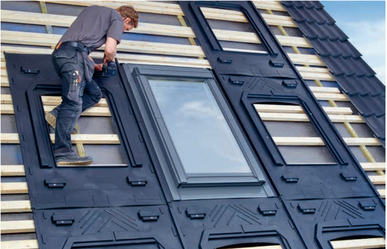
Wanneer het raam volledig is geïnstalleerd, is de installatie van de kunststof kuipen voltooid aan de voorheen vrije zijde en later ook aan de bovenkant. (Foto: VELUX)
