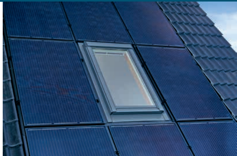
Met het nieuwe gootstuk kunnen dakramen worden geïntegreerd in in-roof PV-systemen van verschillende fabrikanten. (Foto: VELUX)
