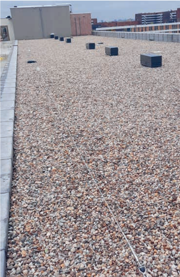
Proefproject met Garantgum 446K14HR, Therma TR29, 15 cm hoge retentiekraften, ballast en Pluvia hemelwaterafvoer.
